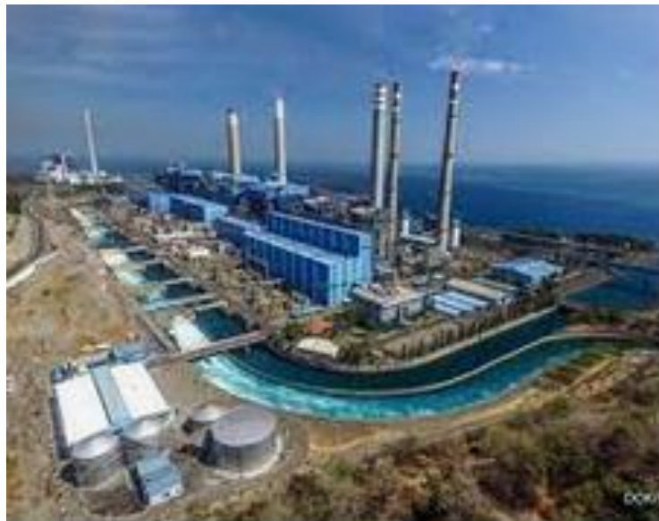
Gambar 16.1. Pembangkit Listrik Tenaga Uap
