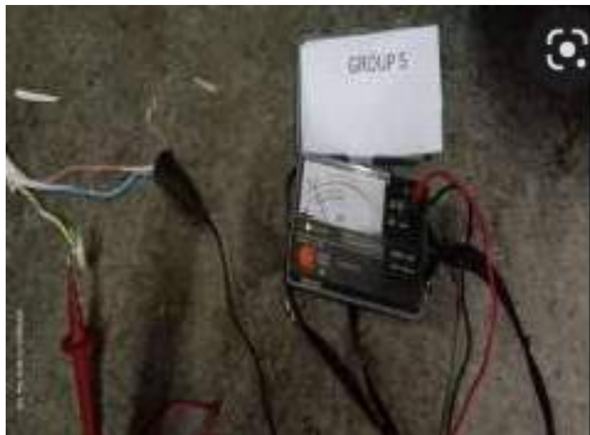
Gambar 12.4. Pengecekan Resistansi Instalasi Listrik
