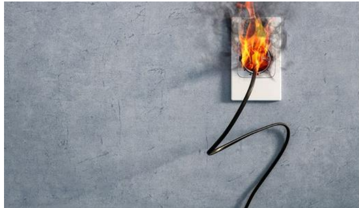
Gambar 12.2. Kebakaran Akibat Listrik
