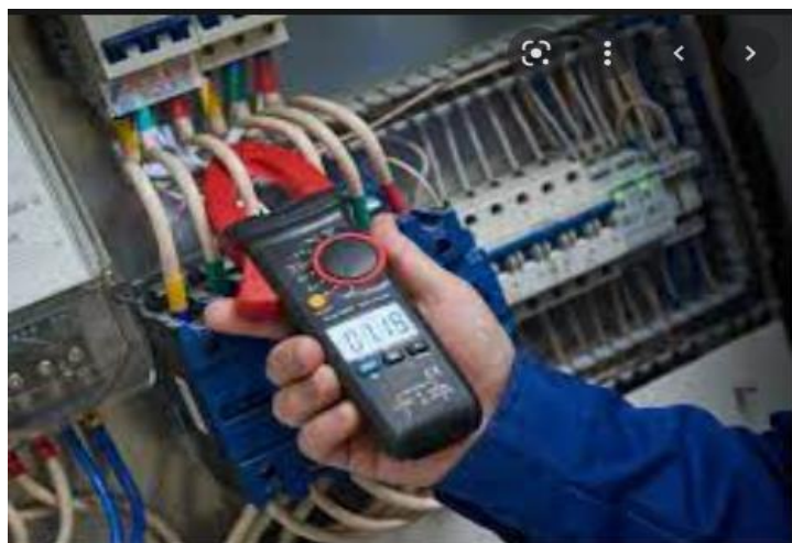
Gambar 12.4. Pengecekan Instalasi Listrik
