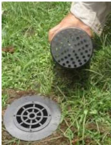
*Gambar 17. Lubang Resapan Biopori*
