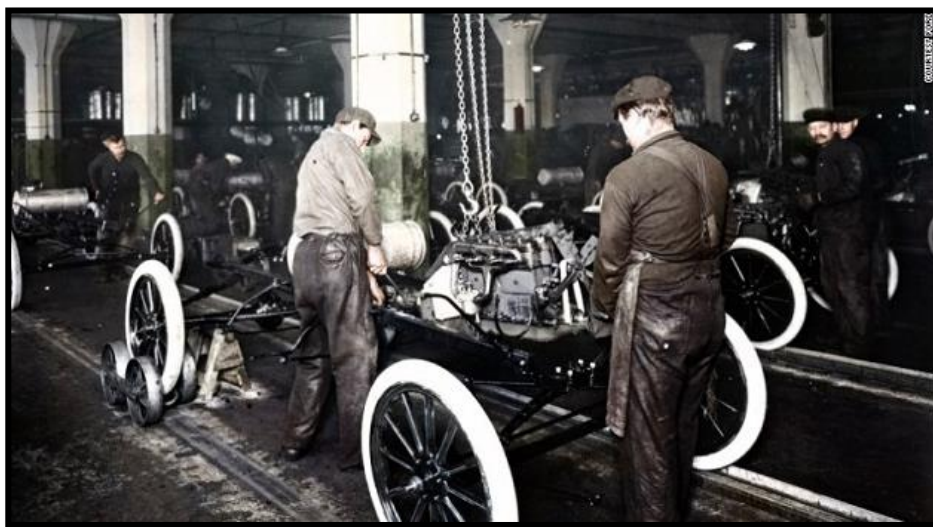
Gambar 1. 4: Penggunaan conveyor belt pada proses perakitan. Sumber : Zenius.net
