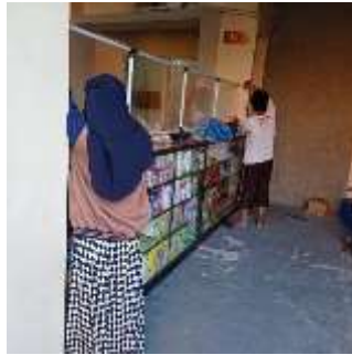
Gambar 10. Proses pemasangan tirai plastik
