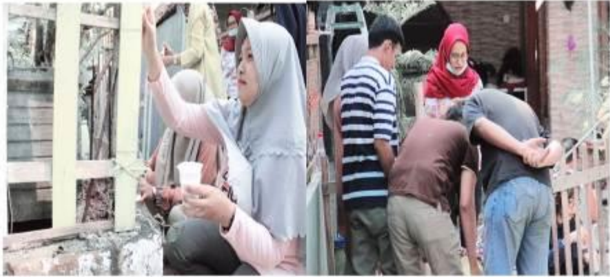
Gambar 7: Pengecatan Pagar Taman
