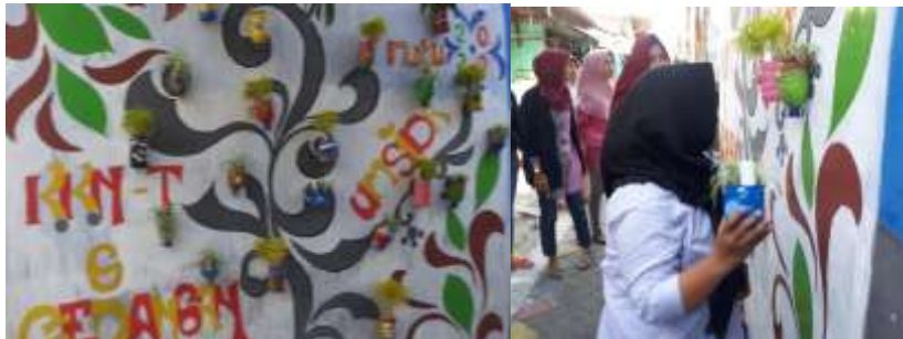
Gambar 31 pemasangan pot untuk vertical garden
