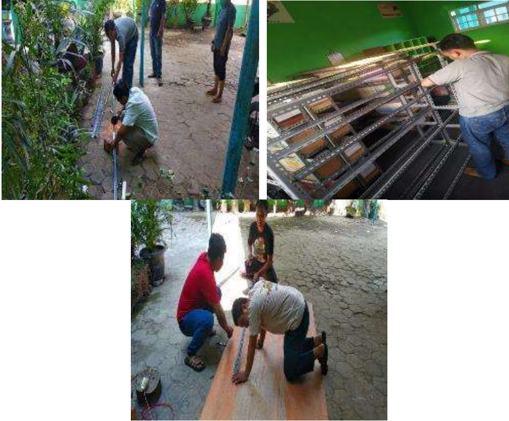
Gambar 5.26 Perancangan dan pemasangan Rak Buku
