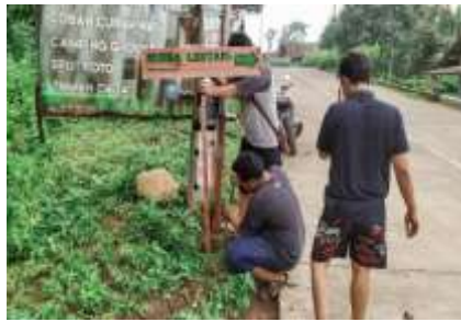
Gambar 1. Pemasangan Papan Petunjuk Jalan
